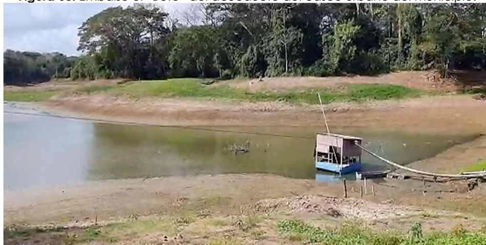
Figura 63. Embalse el "Bote" del acueducto del casco urbano del municipio.
